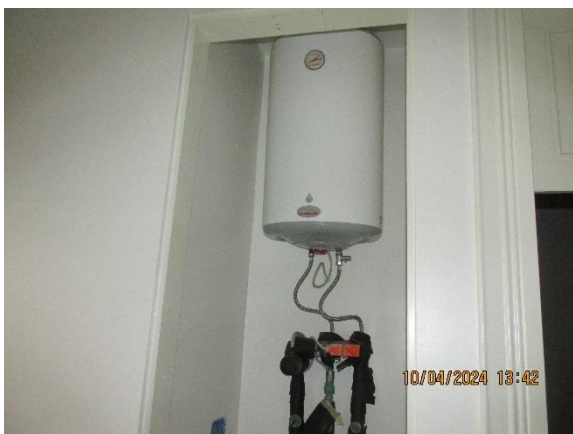
Slika 7. Električni bojler za toplu vodu
